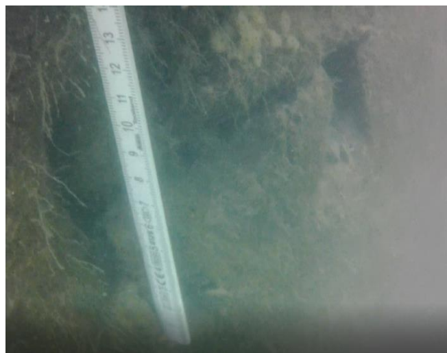
Figure 4 : destruction du bajoyer sous eau
