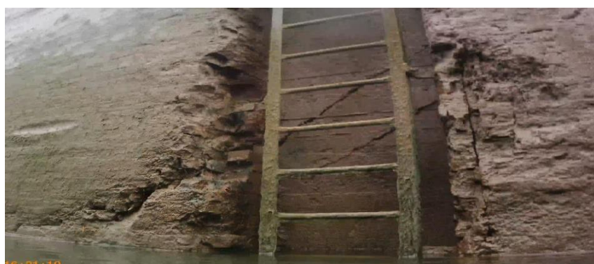
Figure 6 : – destruction horizontale intérieure du bajoyer
